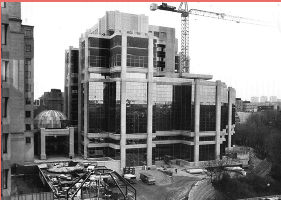
建設中の様子
